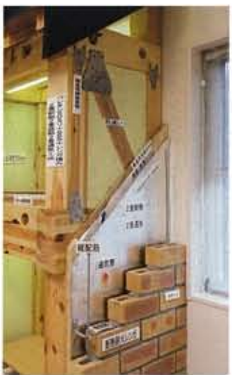
近代ホームの展示場にある壁の構造模型。政府の「200年住宅構想」のもと、より性能アップを目指す。
