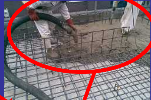
打設と平行して検査します
