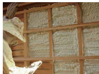
家中をすっぽり断熱材で覆います。
